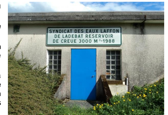
Figure 12 : Réservoir semi-enterré (SIELL)
