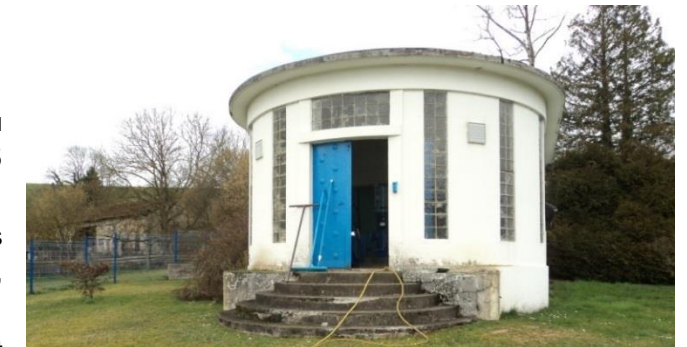
Figure 9 : Puits de Deuxnouds-aux-Bois (SIELL)
